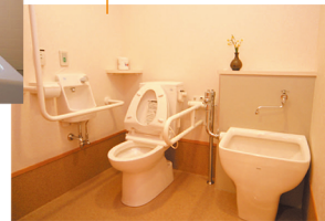
車椅子用トイレ 安全性を十分に考慮した機能的なトイレ。
